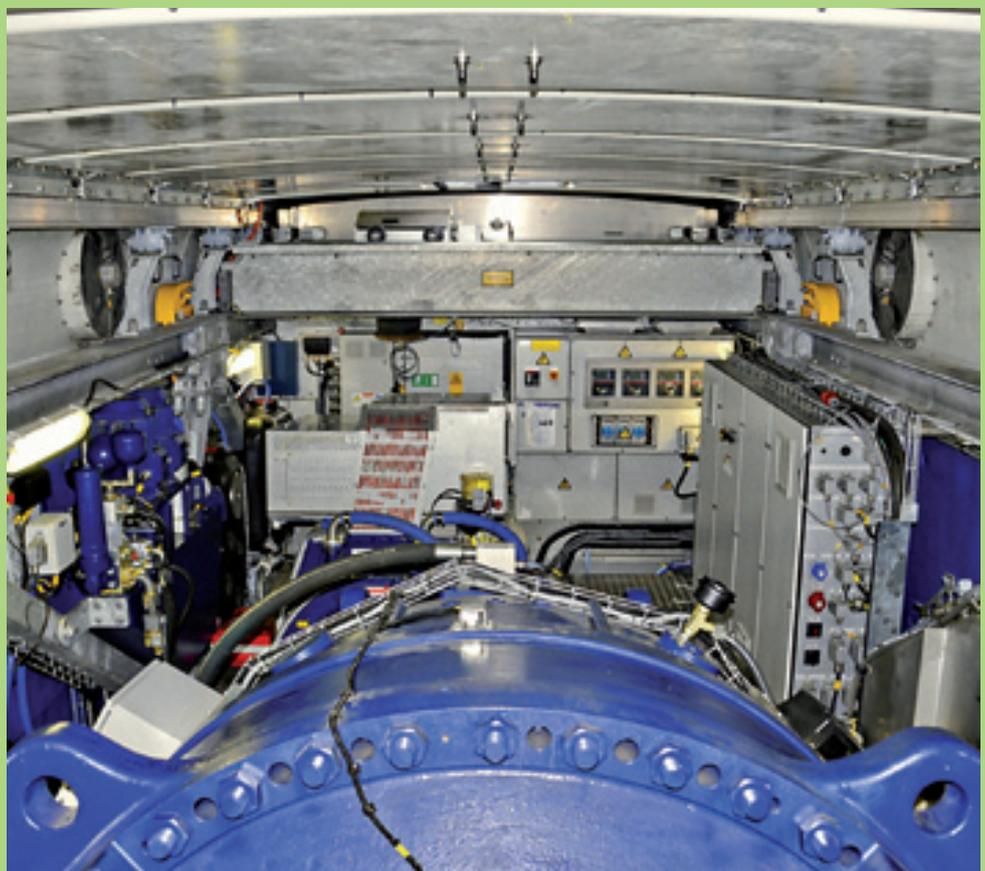
*Blick in die Gondel einer Windkraftanlage: Unter anderem der Arbeitsplatz der HEITEC-Techniker.*
